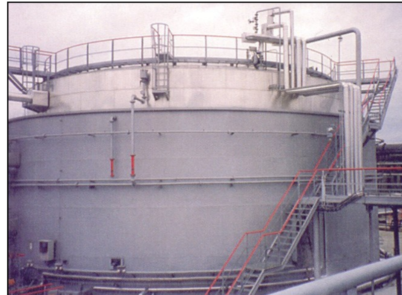
Festdachtank Schwarze Pumpe (3.000 m 3 )
